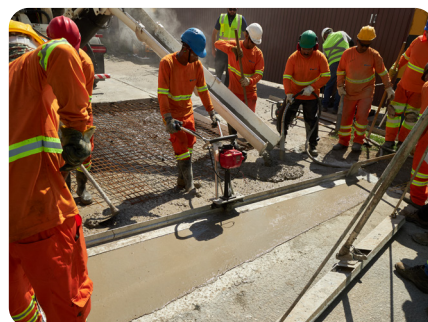
6. Adensamento e nivelamento.
