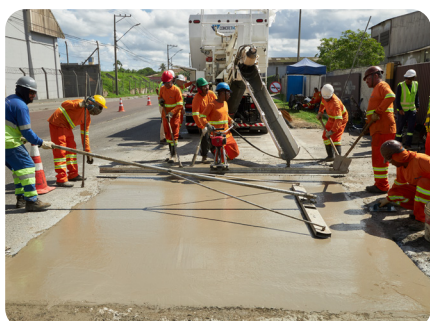
7. Alisamento superficial com float.
