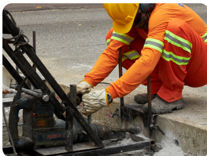
2. Execução dos furos para inserção das barras.
