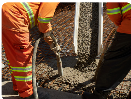
5. Lançamento e vibração.
