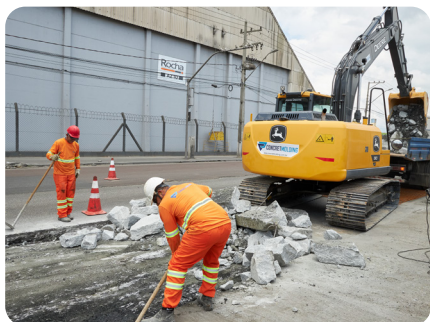
1. Remoção da placa existente.
