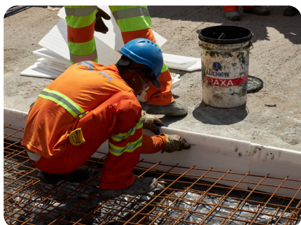
4. Instalação de junta de isolamento em EPS.
