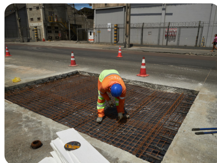
3. Posicionamento da tela de aço.
