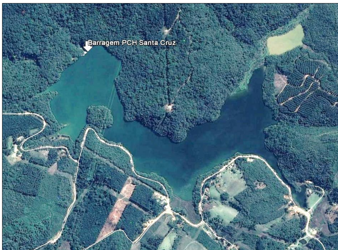
Figura 2. Imagem do Reservatório.
