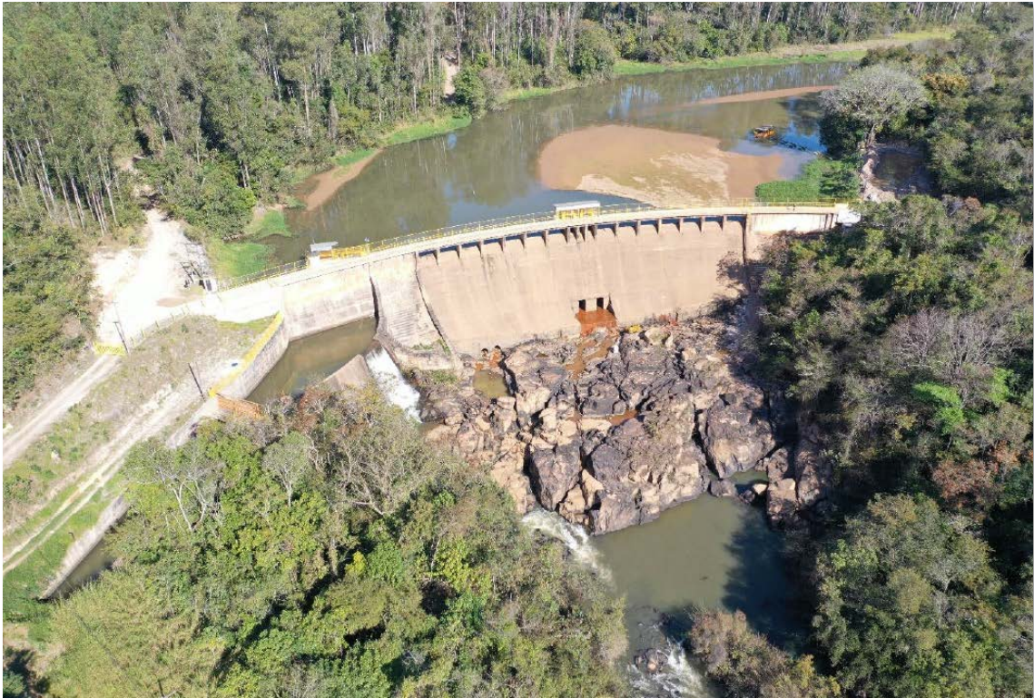
Figura 1 – Barragem e vertedouro da PCH Monte Alto
