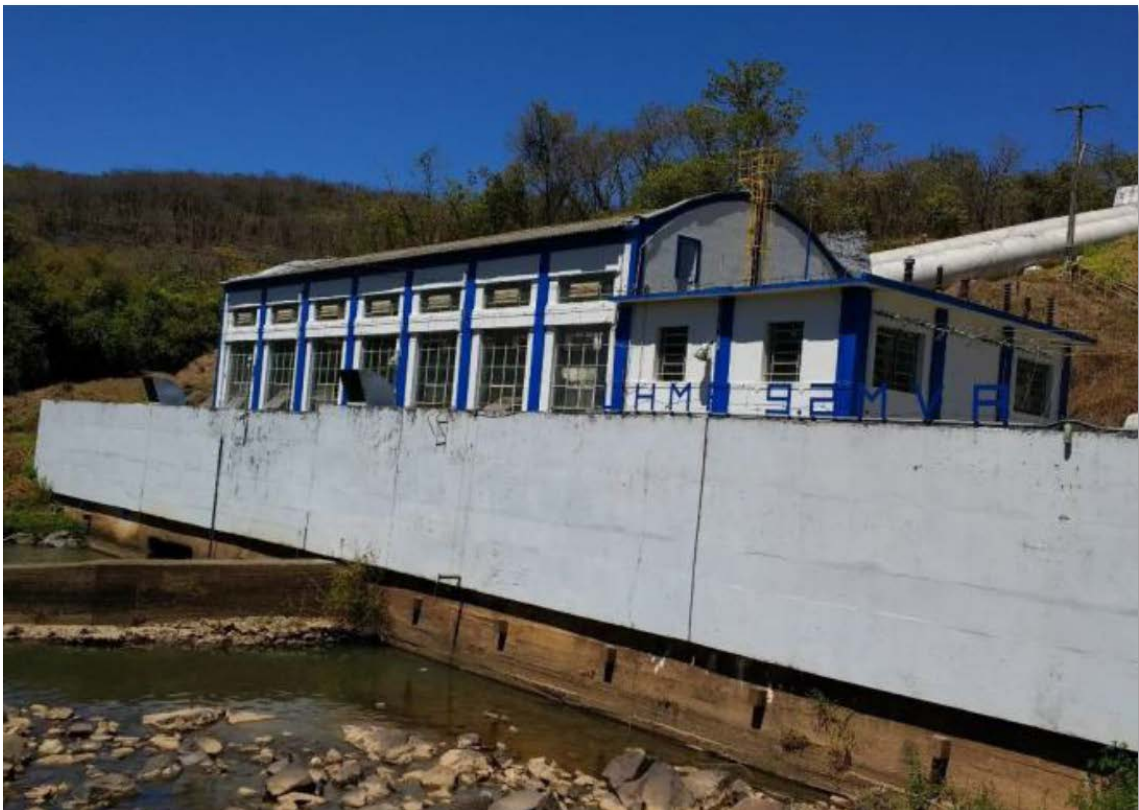
Figura 2 – Casa de força da PCH Monte Alto
