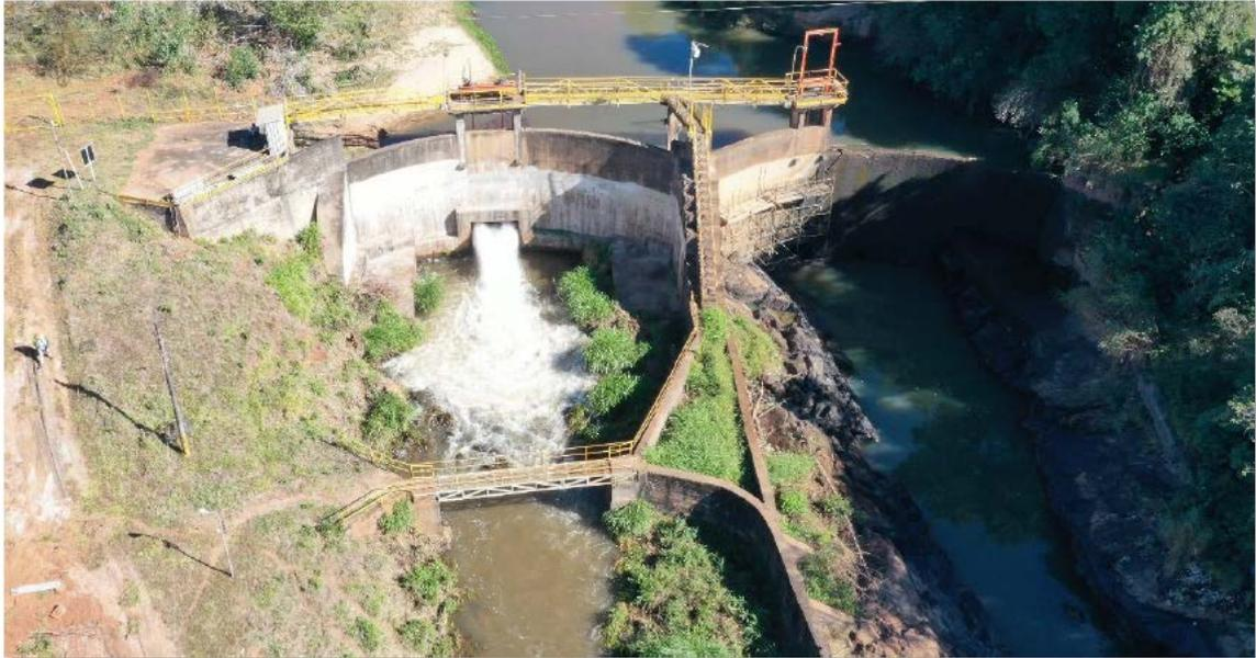
Figura 2 – Casa de Força e Canal de Fuga da CGH Santana
