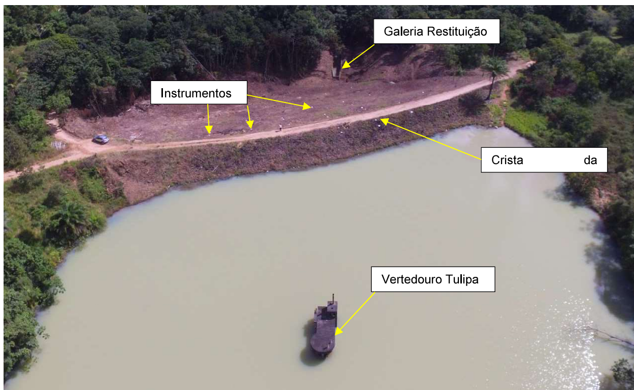
Figura 3 – Estruturas da Barragem Oiti
