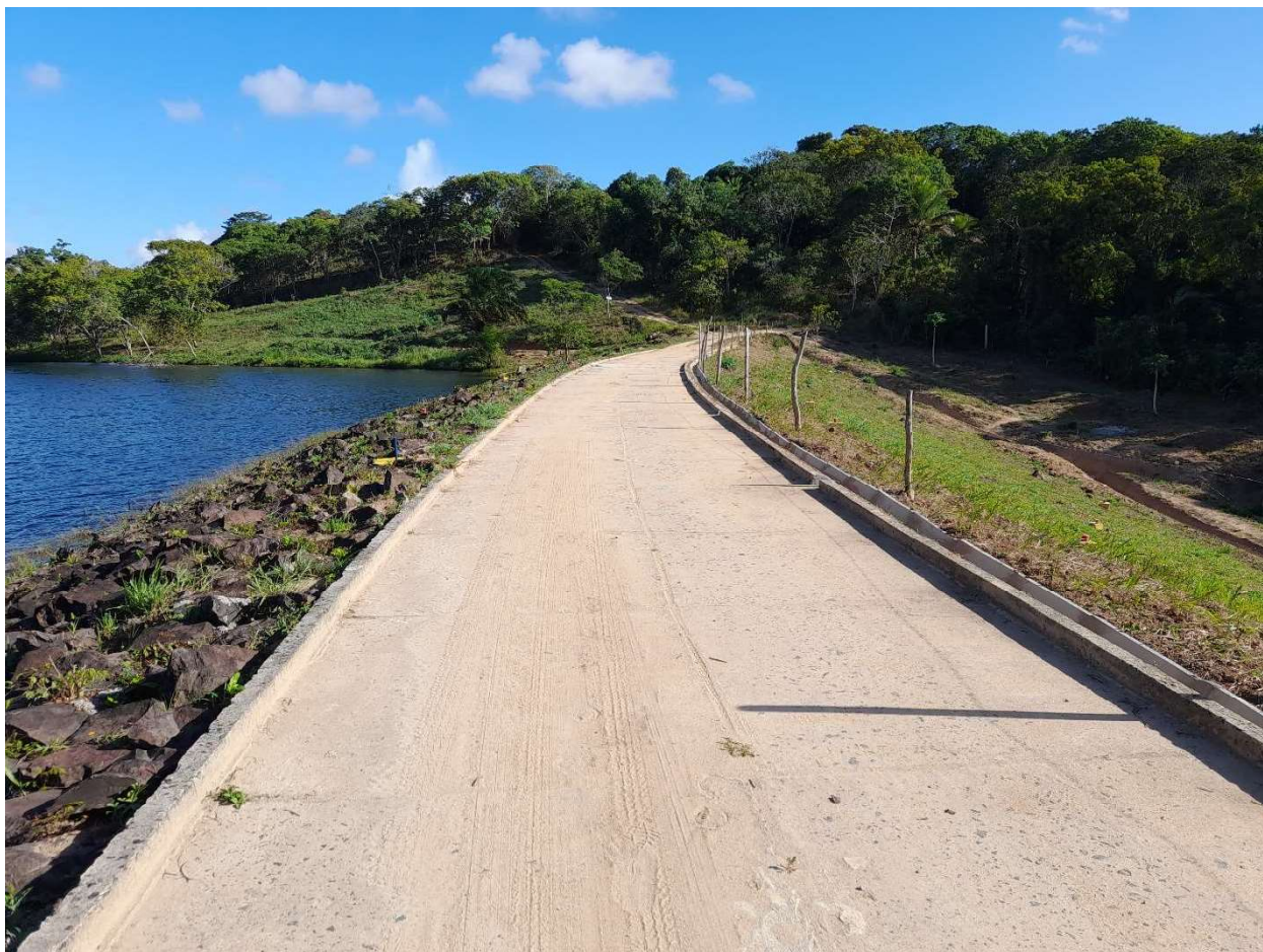
Figura 9 – Vista Geral do Barramento
