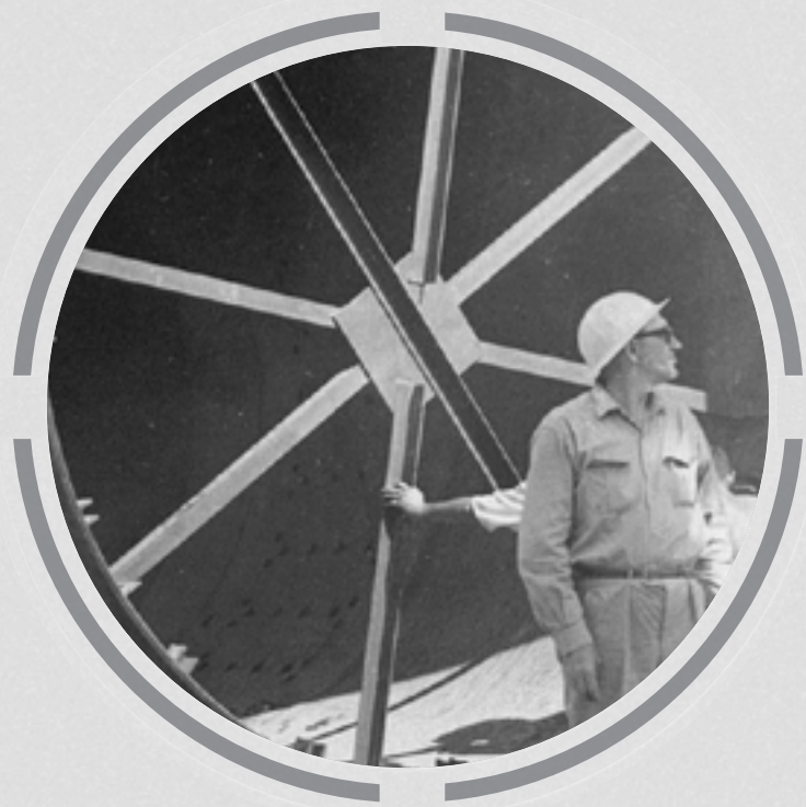
CONSTRUÇÃO DA PRIMEIRA FÁBRICA DE SANTA HELENA, BRASIL
